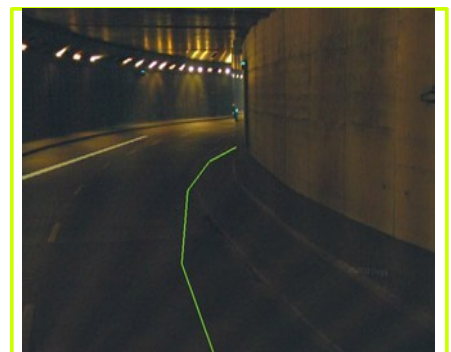
pozycjonowanie SPAN we tunelu
