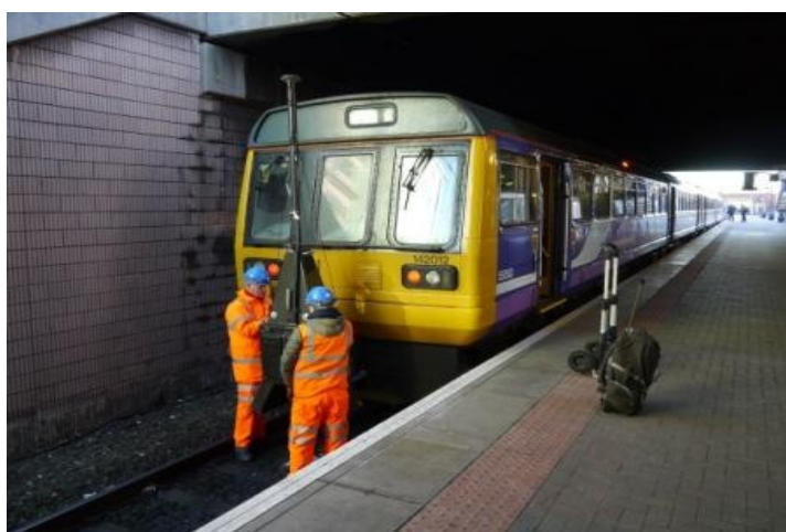
Montaż SPAN na elektrowozie.
