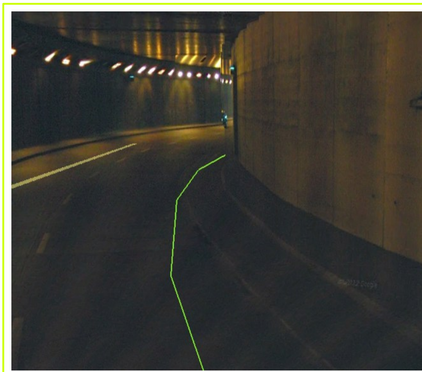
Pozycjonowanie SPAN w tunelu.
